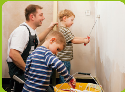
Werken und Arbeiten
